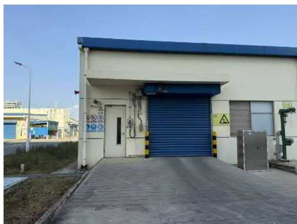
乙类危废仓库
