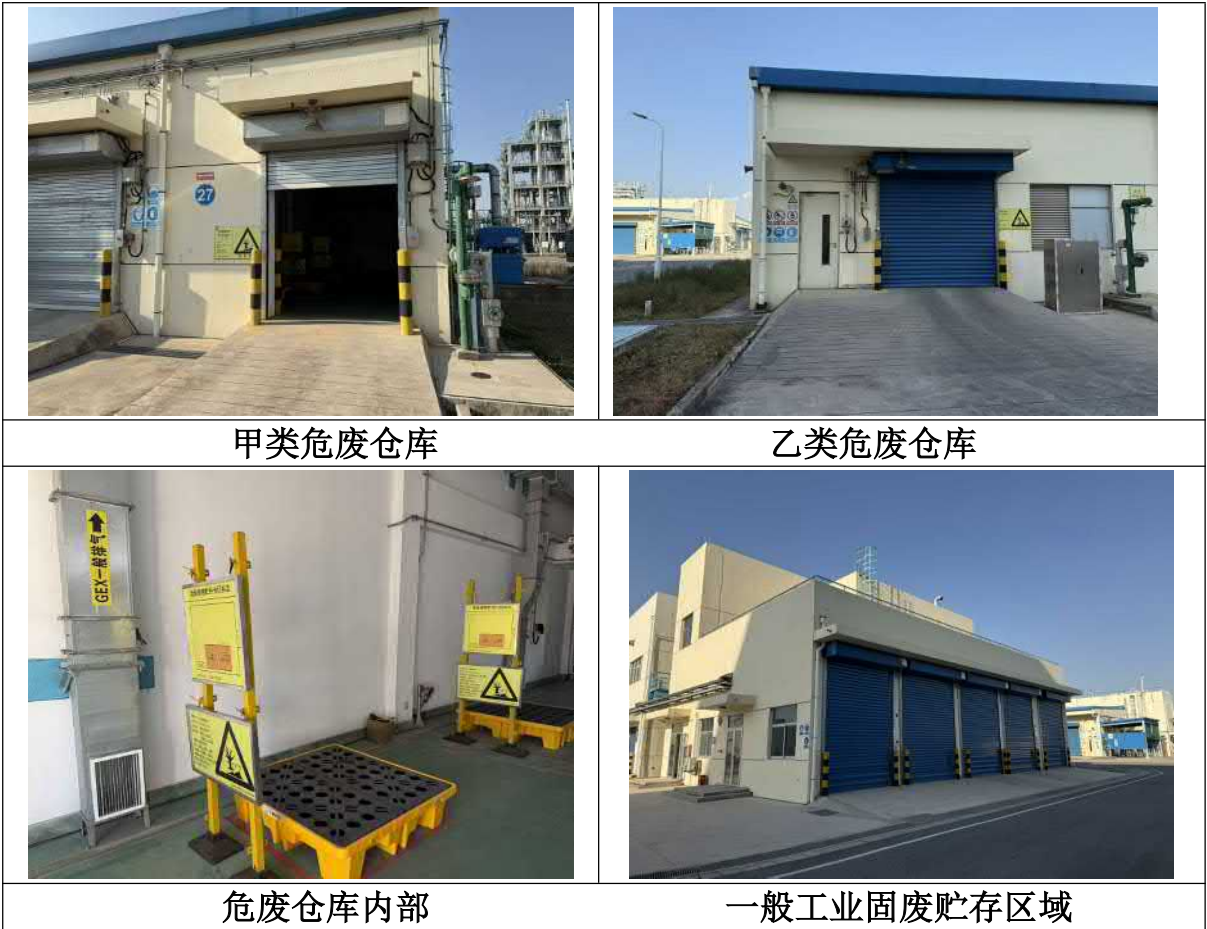
图 3.1.5.4-1 固体废物治理设施图
