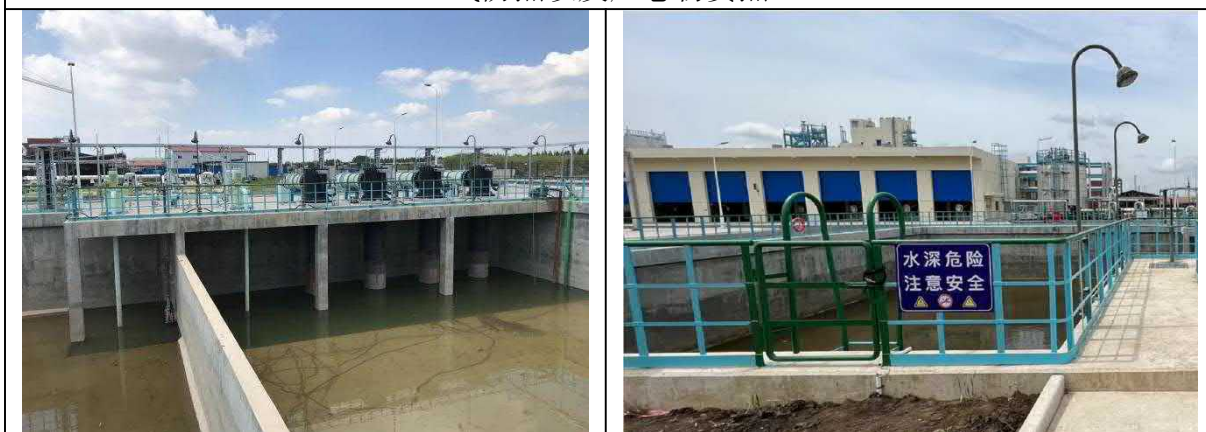
初期雨水池及应急事故池
