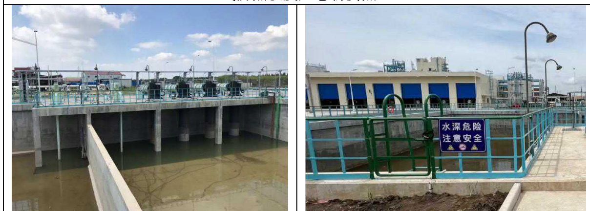
初期雨水池及应急事故池
