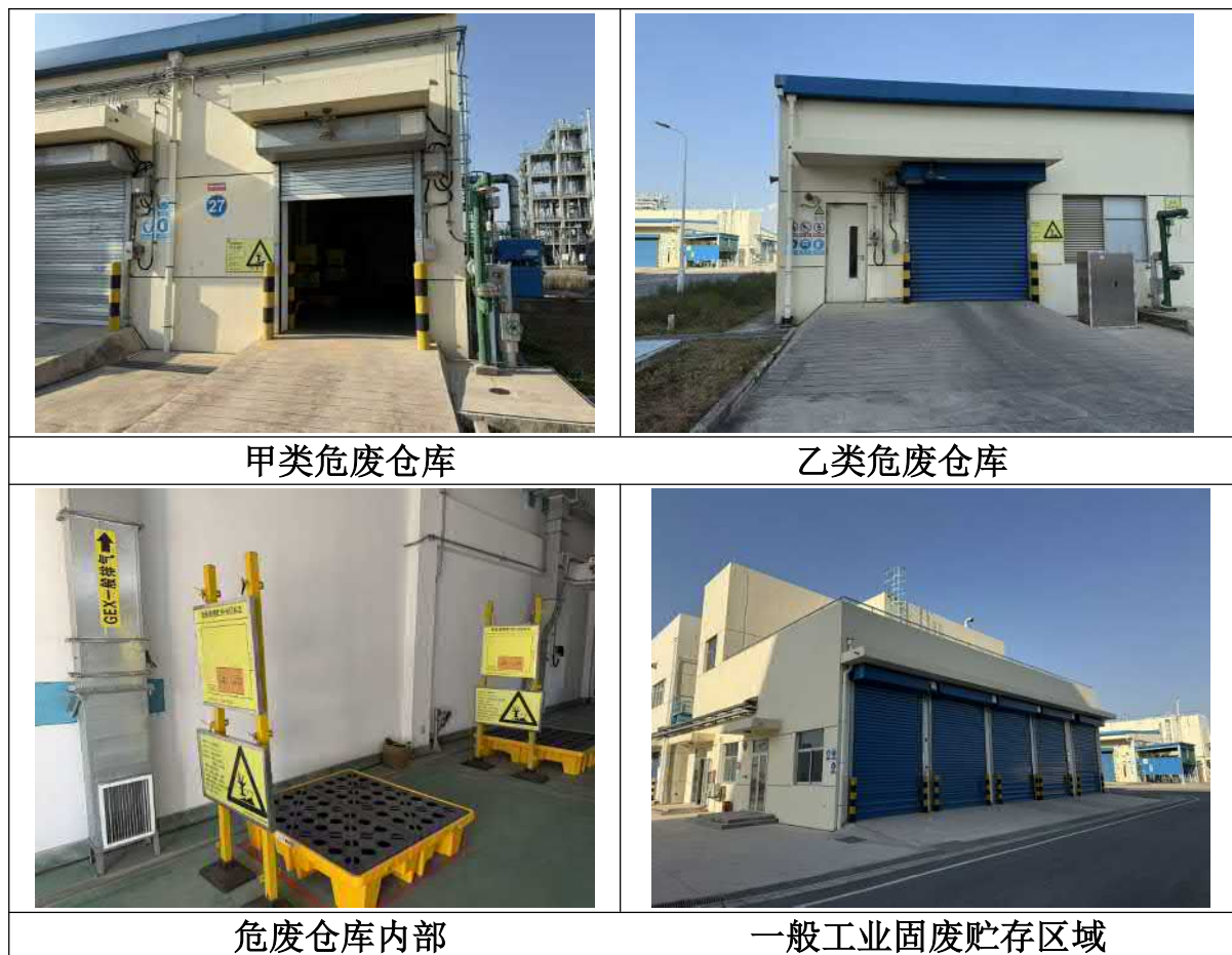
图 3.1.5.4-1 固体废物治理设施图
