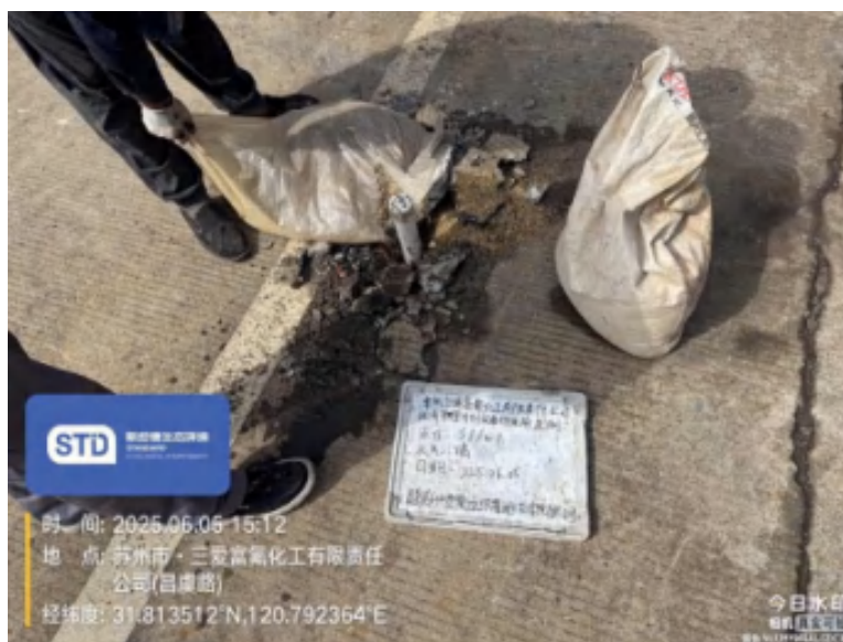
图 6.1-4 滤料填充照片
