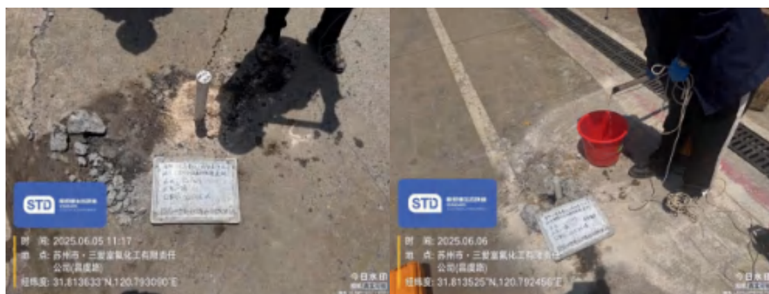
图 6.1-6 成井洗井照片
