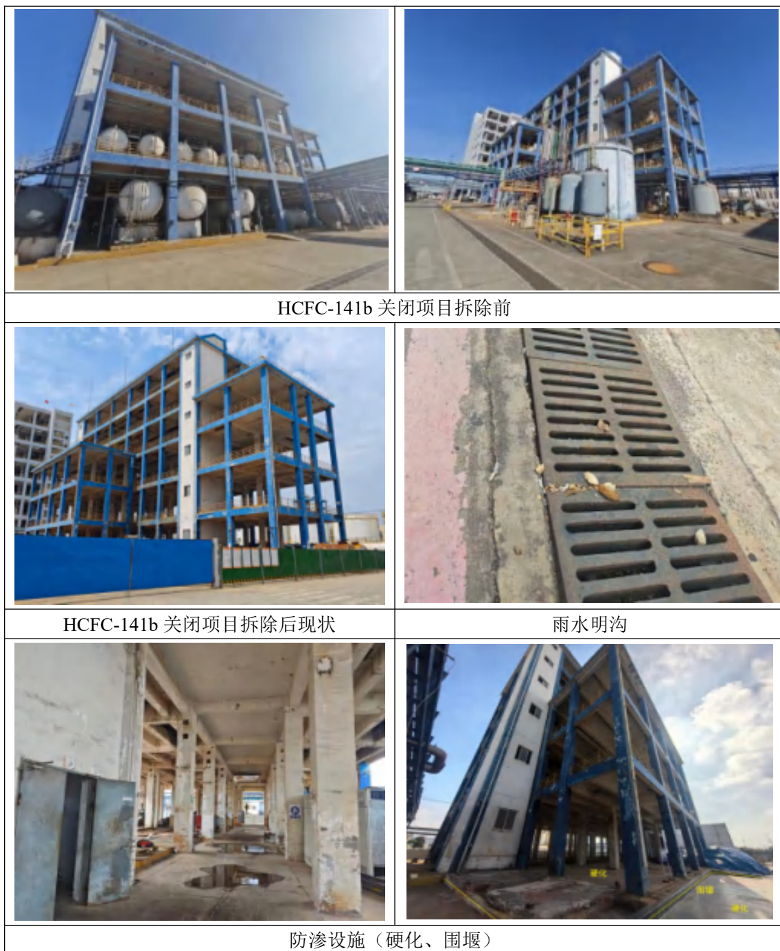
图 3.4-1 HCFC-141b 生产区拆除前、后及各设施照片
