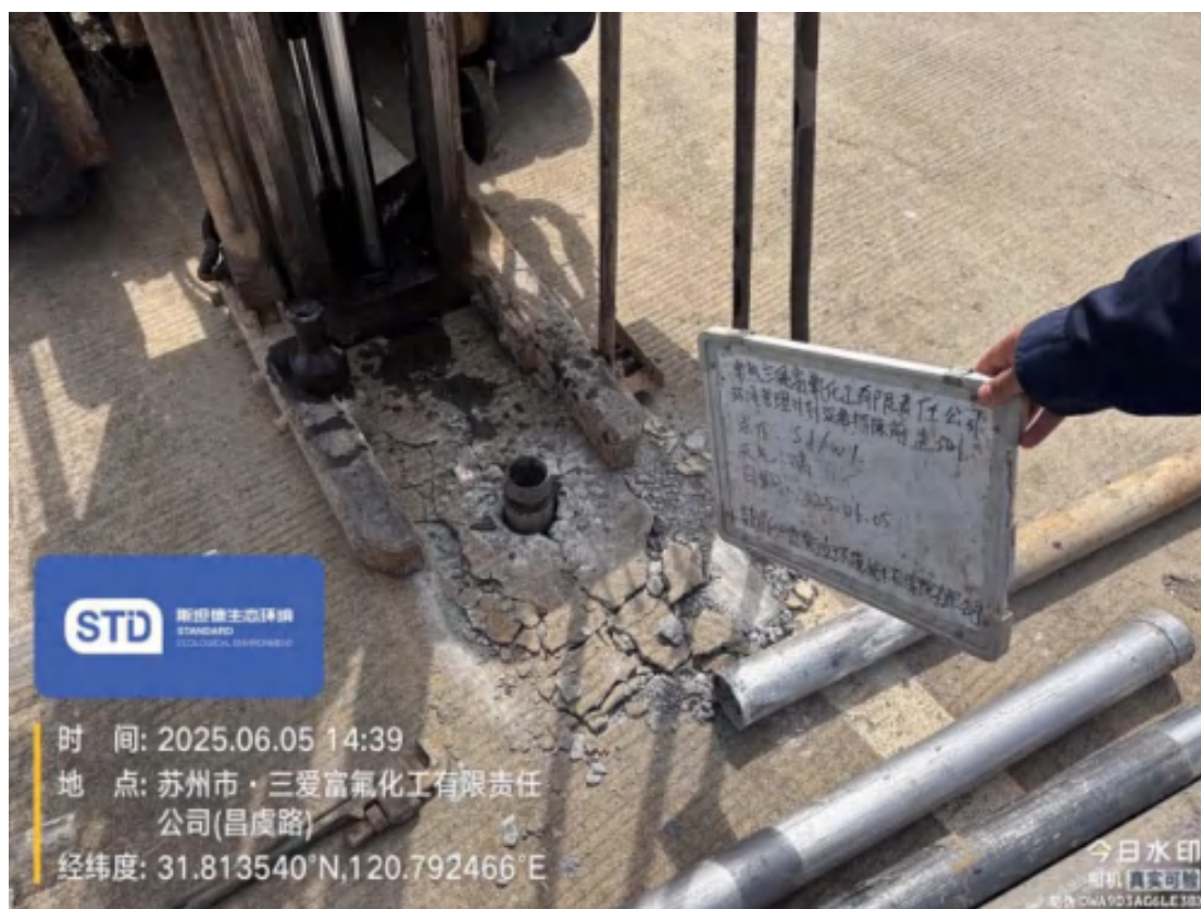
图 4.3-1 第一次（设备拆除前）现场工作照片
