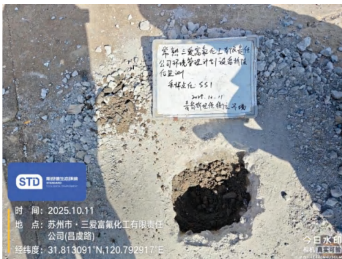
图 4.3-2 第二次（设备拆除后）现场工作照片
