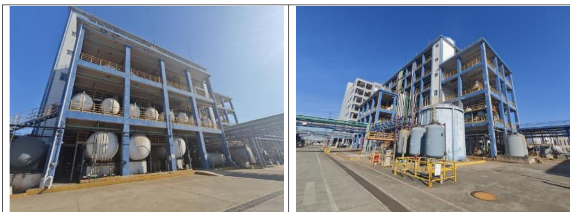
HCFC-141b 关闭项目拆除前
