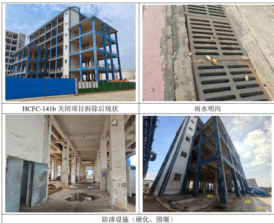
图 3.2-3 HCFC-141b 生产区拆除前、后及各设施照片
