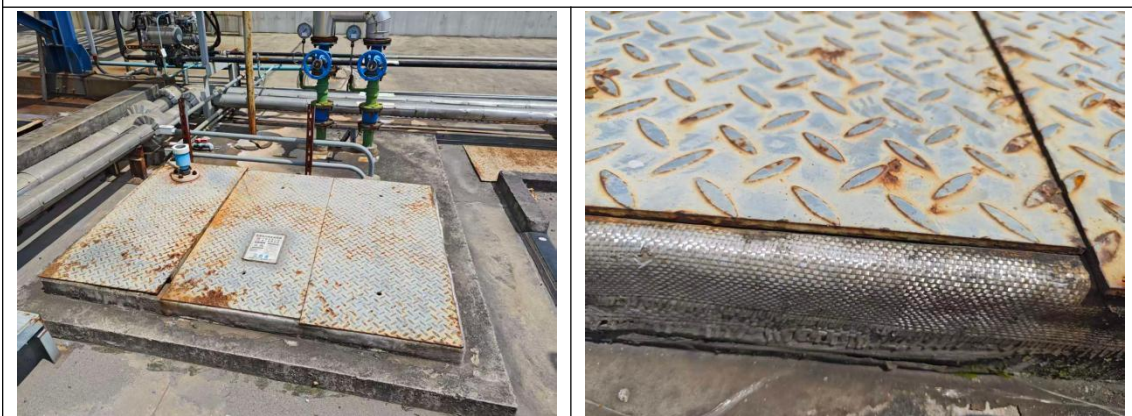
废水收集池及防渗
